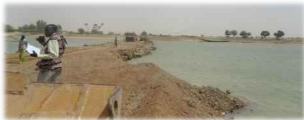
Travaux du barrage de Kandadji au Niger
